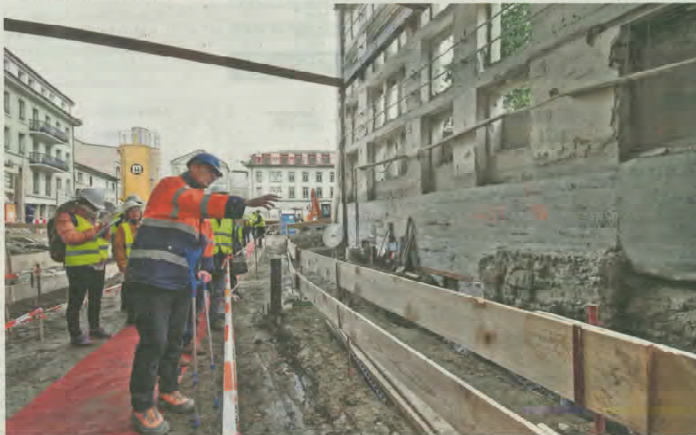
Der verantwortliche Ingenieur Eric Gysin führt über die Baustelle der Kantons- und Universitätsbibliothek.
